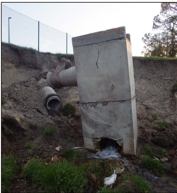
Figure 45. Damaged drainage structure 3 (Latitude 28°41'9.08"N / Longitude 81°30'22.39"W).
