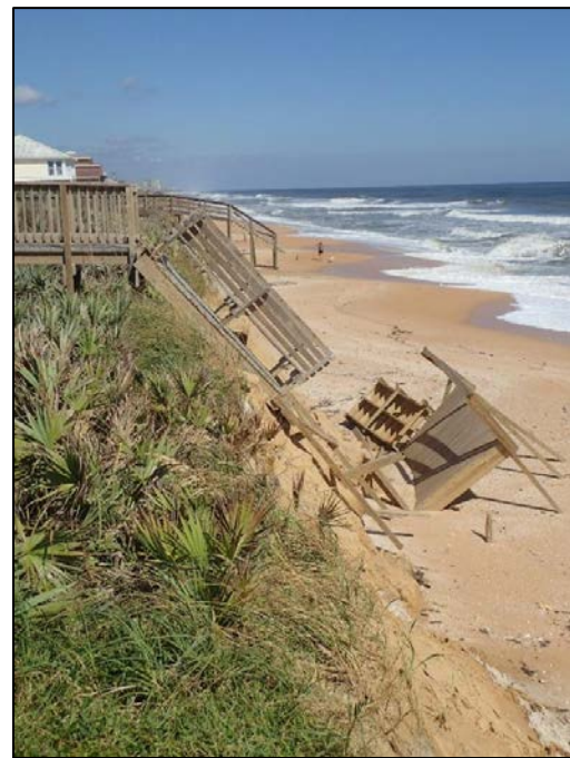
b) North wing wall scour of the timber sheet pile wall (Latitude 29°32'28.35"N / Longitude 81°9'27.15"W).
